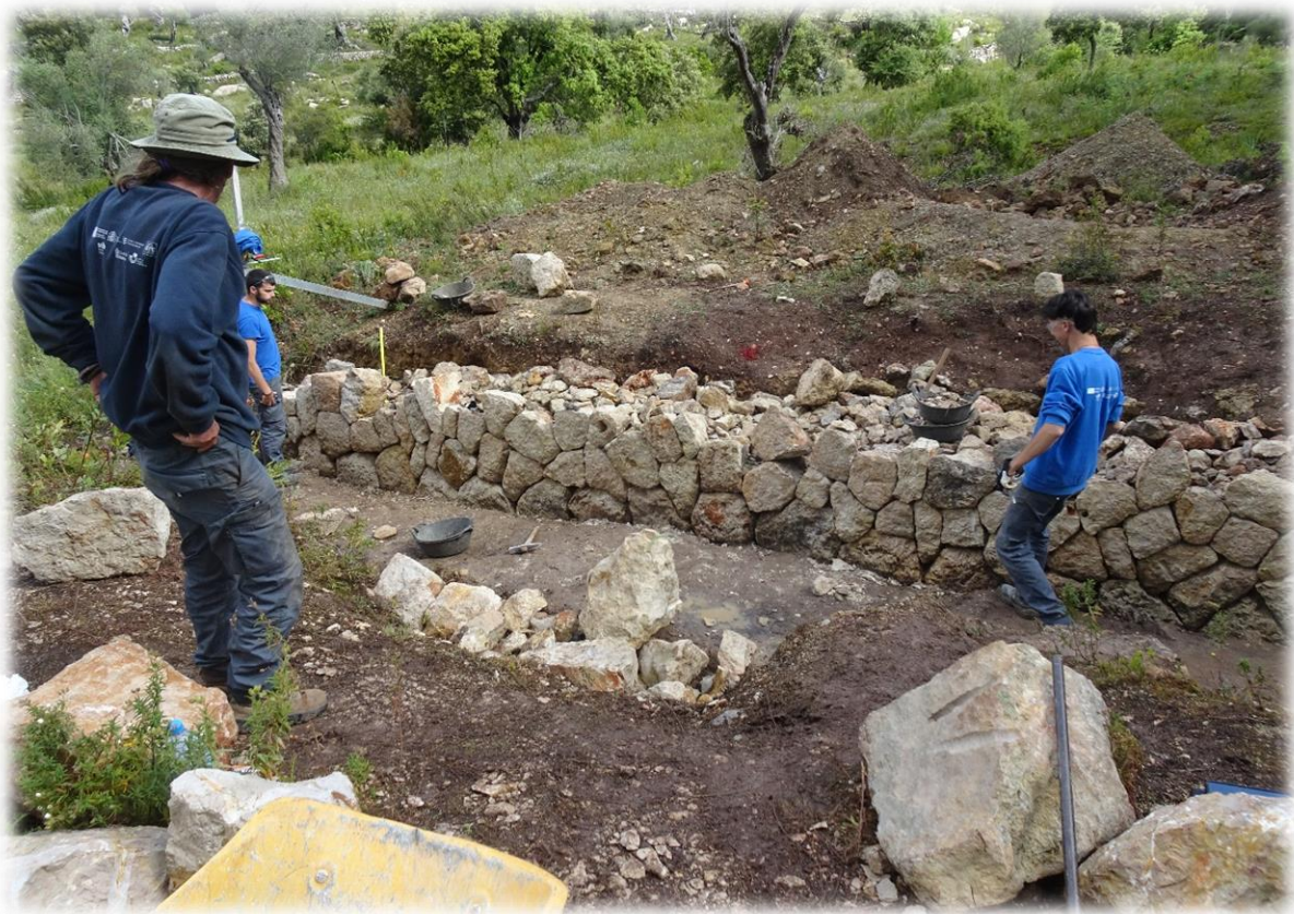
Arbeiders zijn aan het werk om, langs de weg, een waterleiding aan te leggen.
